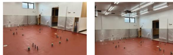
所定の硬化養生時間の後、硬化状況を確認してお引渡し
