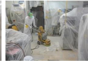
下地コンクリート表面を研削処理
