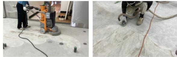
下地コンクリート表面を研削処理
