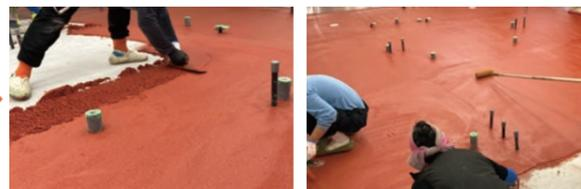
機能層の塗布後、樹脂浮きが均一になるよう、ローラーでならし、テクスチャを整える
