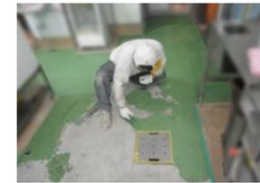
耐熱タイプのMMを塗布(工期短縮のため速硬化剤を使用)
