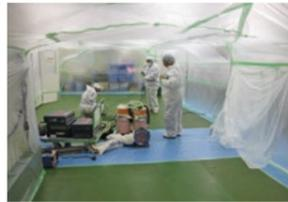
稼働中の食品工場のため、周囲と天井をビニールで囲い、作業区画を隔離
