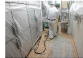
防汚養生後、研削機で既存塗膜撤去
