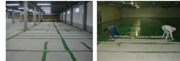
欠き込みやクラック処理部に材料を充填
