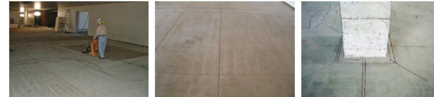
専用機械で研削して強度層を露出させる
