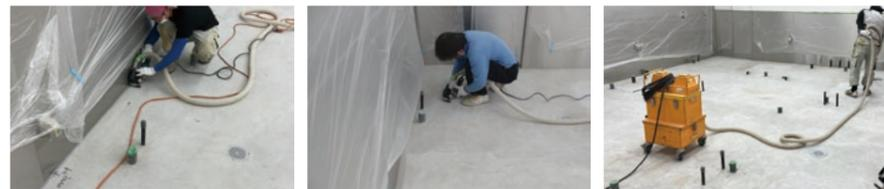
効率が優れた専用機械で欠き込み施工
