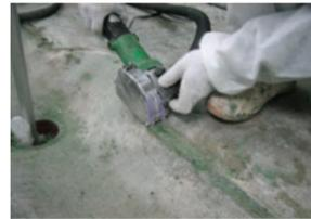
吸塵機能付カッターで欠き込み施工
